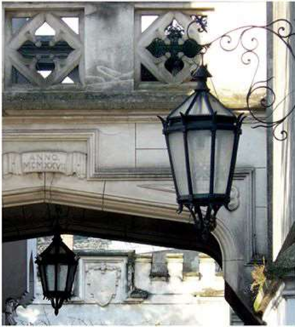
Faroles de la fachada.
