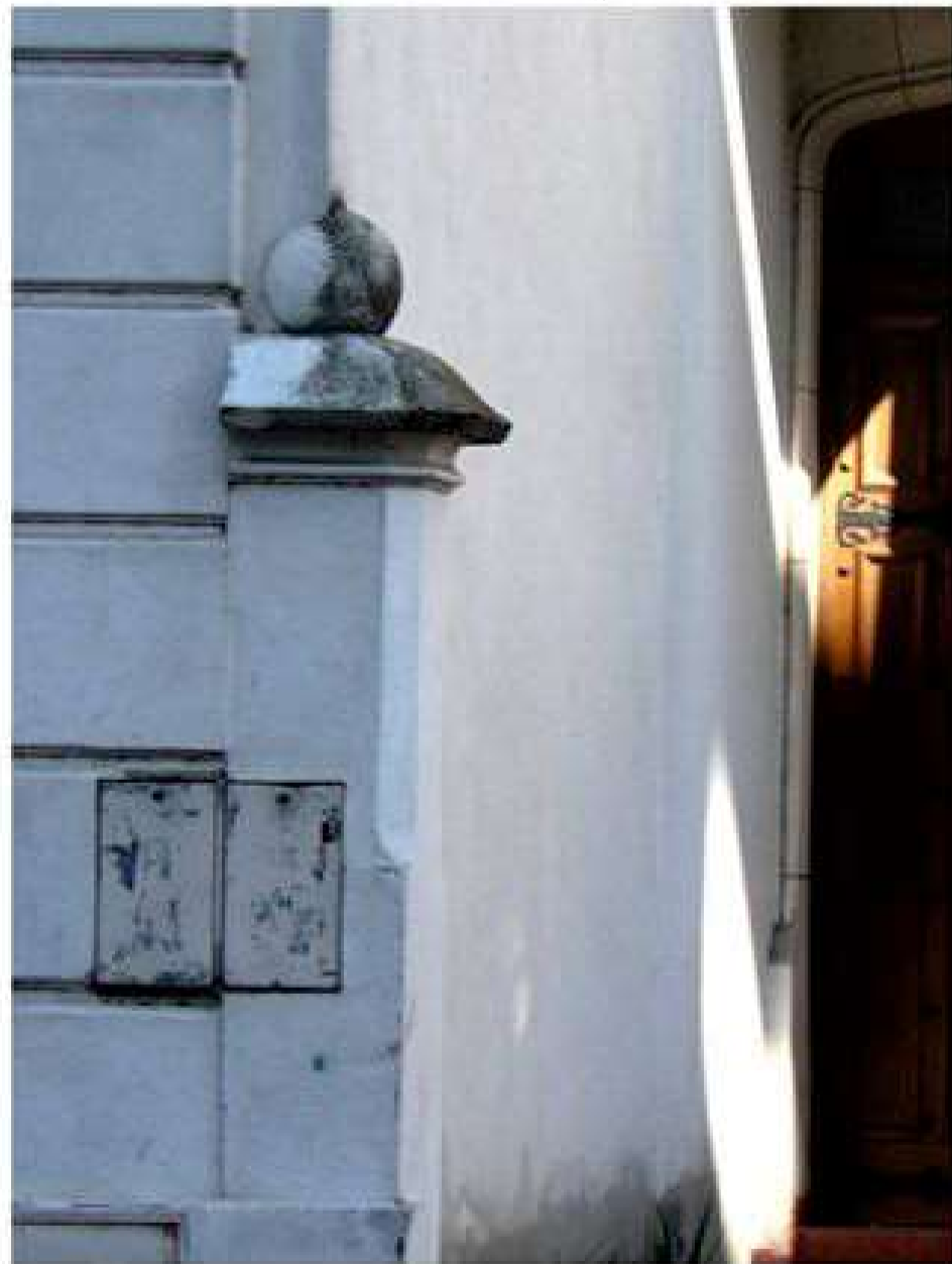
Detalle de la verja intervenida.
