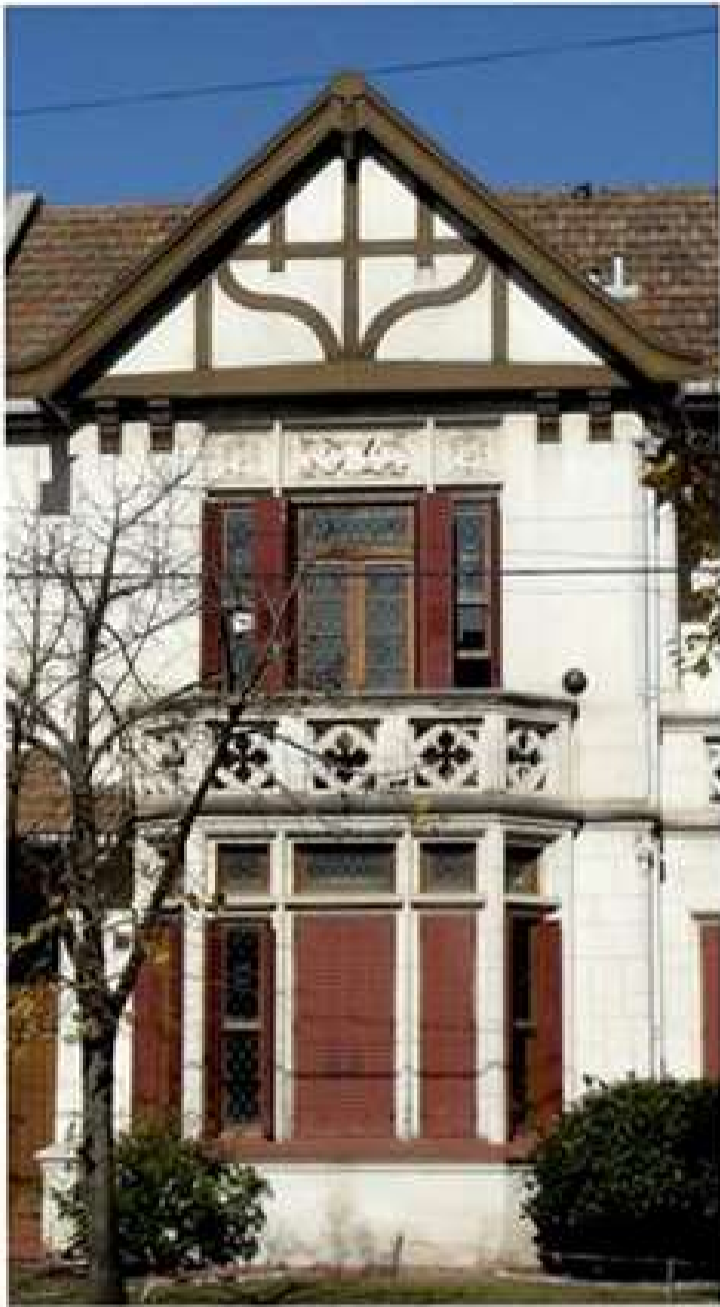
Muro adelantado de la fachada.
