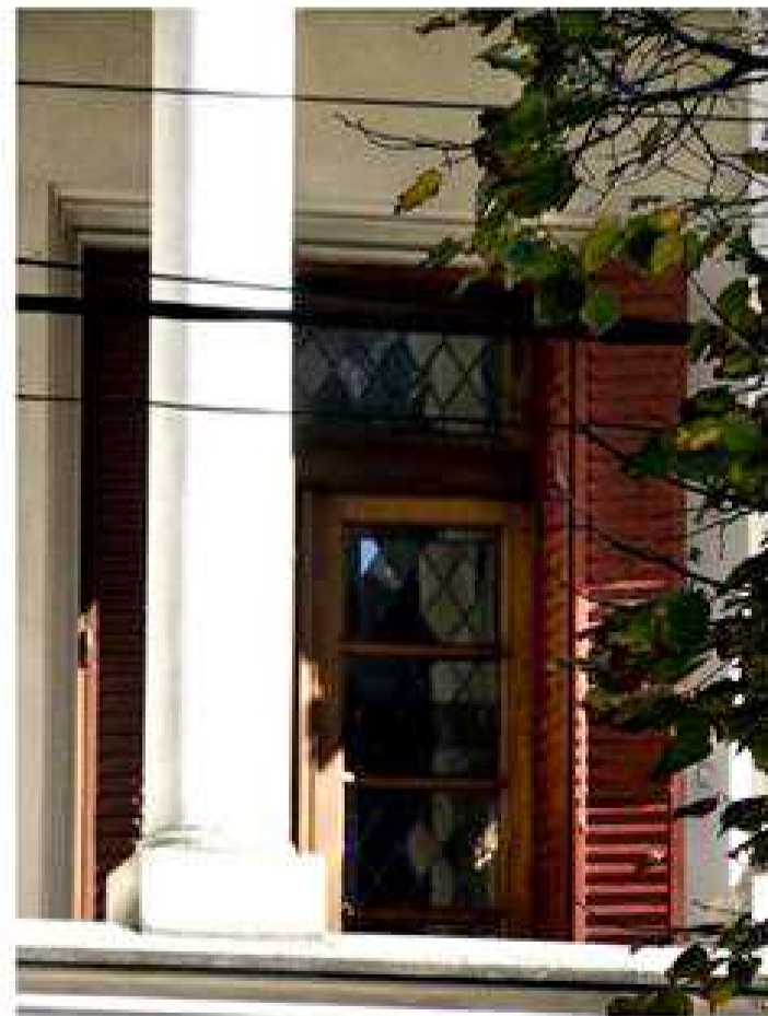
Detalle del ventanal del balcón.
